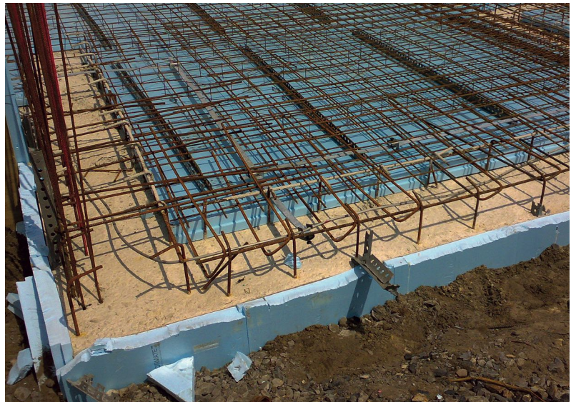
Bild 25: Perimetergedämmte Fundamente mit Erdfähigkeit
