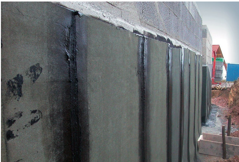
Bild 22: Ausführungsbeispiel einer „schwarzen Wanne“ mit Bitumenschweißbahnen
