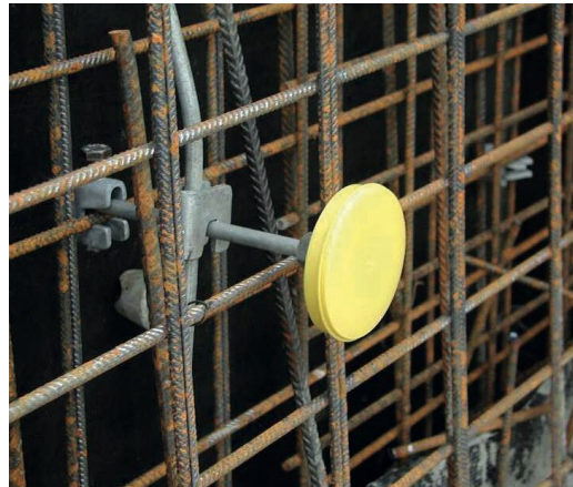
Bild 11: Erdungsfestpunkt
