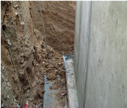
Bild 10: Ausführungsbeispiel einer Anschlussflanke aus Edelstahl (V4A)
