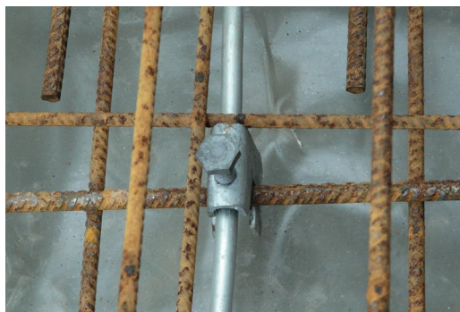
Bild 17: Ausführungsbeispiel für Fundamenterder in der unteren Bewehrungslage
