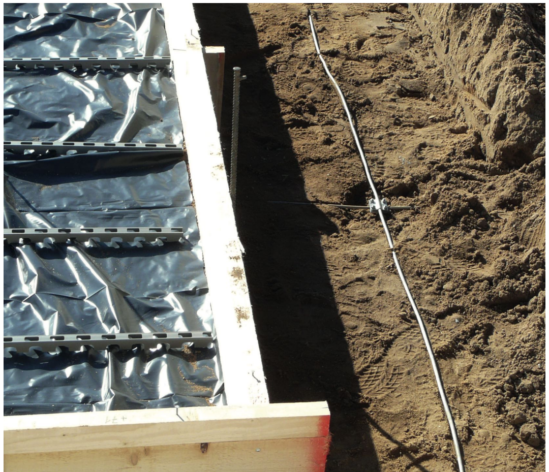
Bild 6: Beispiel für die Ausführung eines Ringerders
