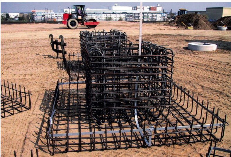
Bild 19: Fundamenterder und Anschlussfahne bei einem Einzelfundament
