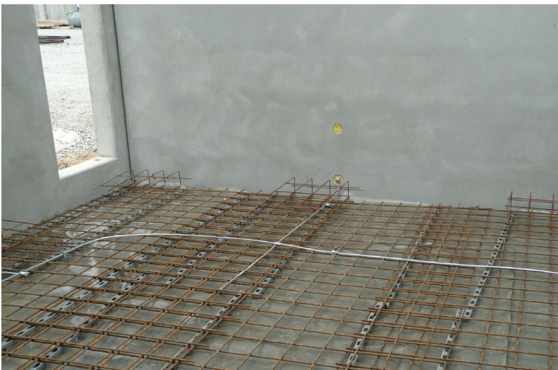
Bild 7: Beispiel für die Ausführung des Funktionspotentialausgleichsleiters
